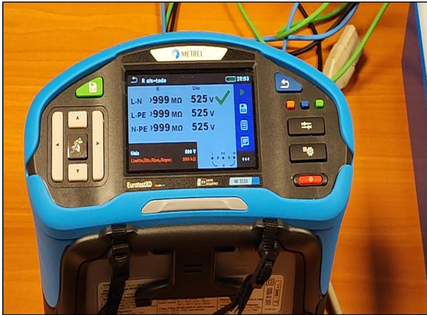
Prueba de resistencia de aislamiento de la instalación eléctrica por cada circuito del TDA.
