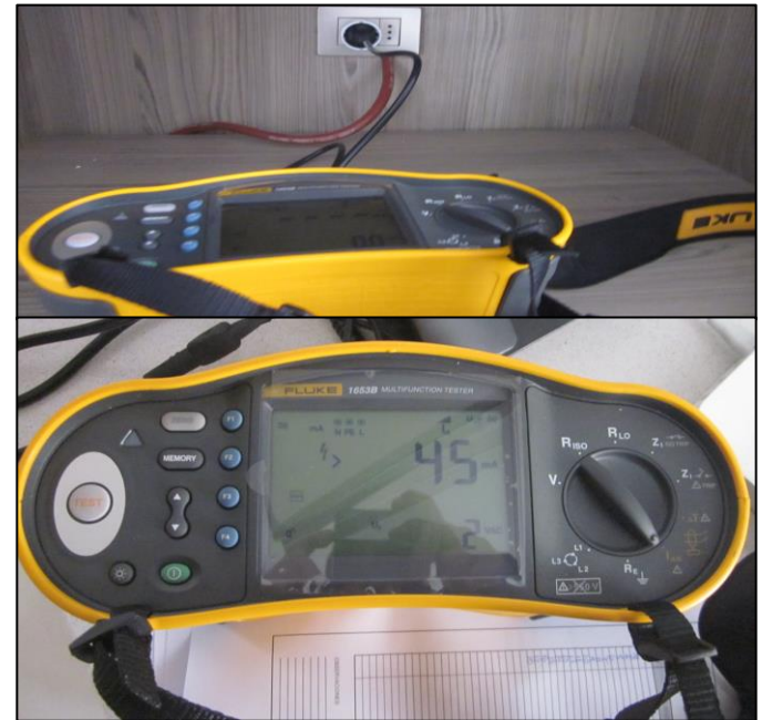
Prueba de medición de RCD, mostrando la operación del protector diferencial, simulando una falla en uno de los enchufes del circuito que está protegido, pasando la prueba de operación en tiempo y corriente (Prueba de funcionalidad).
