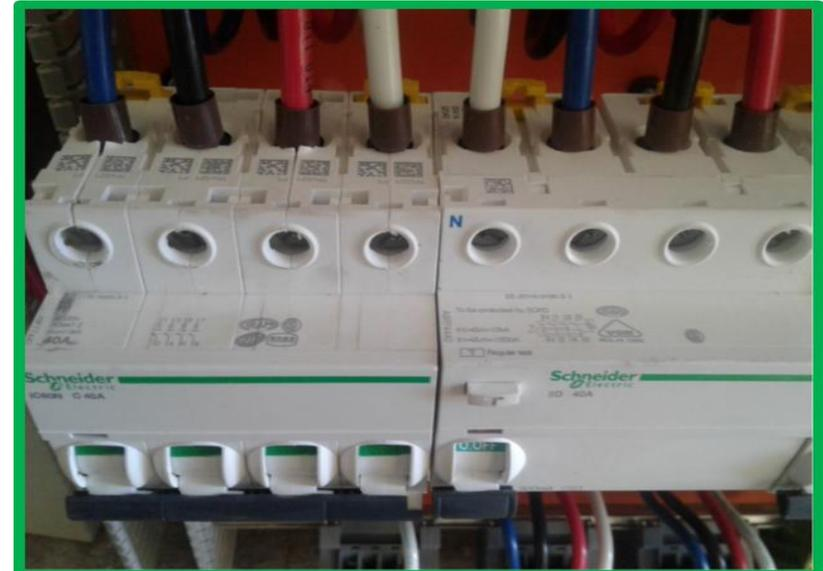
El diferencial deberá ser del tipo A o B y su corriente diferencial no será superior a 30 mA para unidades de generación para potencia instalada inferiores a 10 kW, mientras que para unidades de generación igual o superior a 10 kW su corriente diferencial no será superior a 300 mA.
