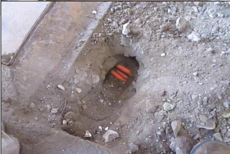
7.9.6 En las canalizaciones subterráneas **está prohibido el uso de conductores designados** como para instalarse en ambientes secos o húmedos, en particular los tipos THW, THHN, THWN, NSYA, H07V-K, H07V-R, H07V-U, H07Z1-K, H07Z1-R H07Z1-U7Z1-R.
